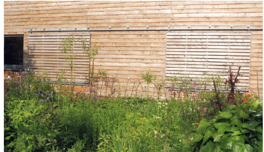
Abb. 13: Lamellen-Schiebeelemente verhindern die Kollision von Vögeln mit Glasflächen des Artenschutzhauses zur Gartenseite. Foto: Volker Tiemeyer, 28.05.2021
