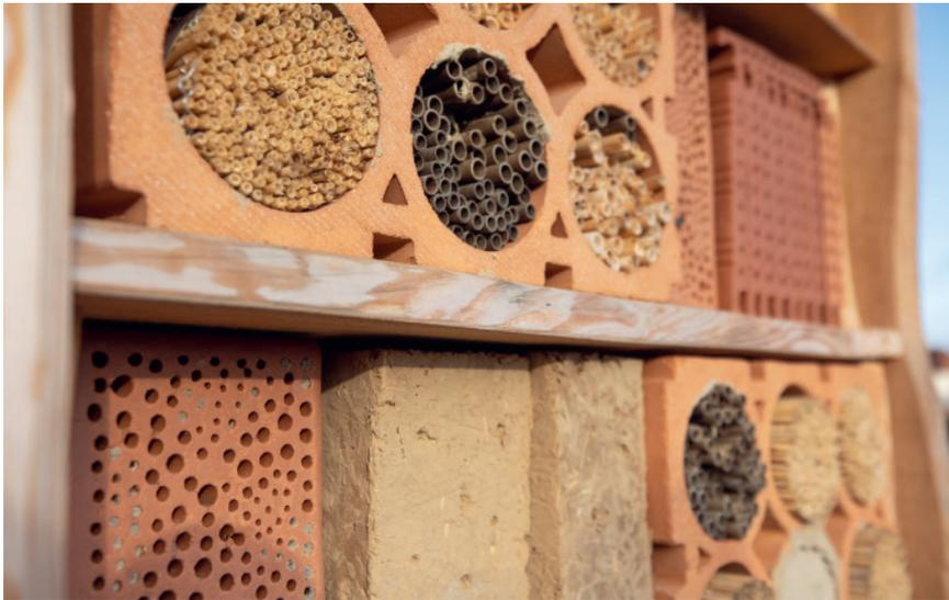
Abb. 16: Verschiedene Materialien wie Schilfstängel, Pappröhrchen, gebrannte Ziegel, Lehm und Strangfalzziegel sind in der Insektennistwand im Einsatz.
