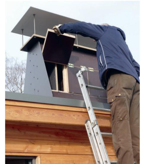
Abb. 11: Am höchsten Punkt des Artenschutzhauses wurde eine Attrappe eines Schornsteins als Nistmöglichkeit für die Dohle montiert.
